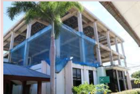
Pembangunan Gedung baru Coass oleh FK Unbrah di RSUD M.Natsir
